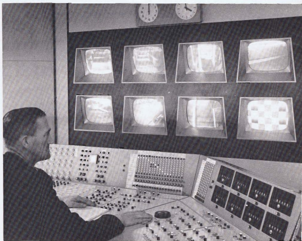
Fig. 21. Controle-kamer van de TV-installatie in het hoofdkantoor in Rotterdam
